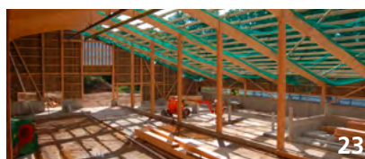
Der Bau eines neuen Gebäudes stellt eine grosse Investition dar.
