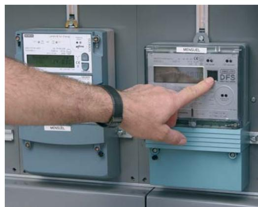
Der Zähler links zählt den Strom, der ins Netz gespiesen wird, der Zähler rechts steht fast immer auf null, denn er misst die Strombezüge aus dem Netz.
