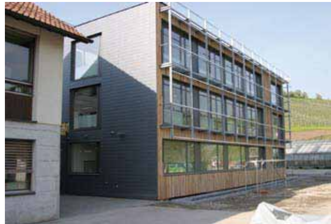
Die Fassade des von den Fricker Architekten Daniel John und Vinzenz Reist konzipierten Gebäudes ist mit Lärchenholz verkleidet und wird noch begrünt.
