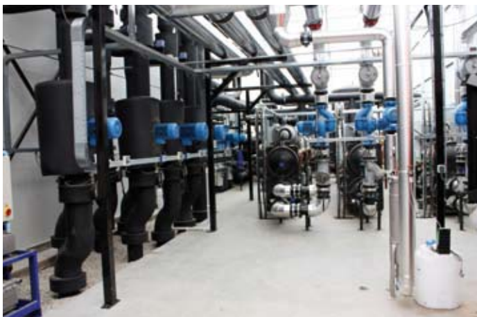
Immenser Technologieinput verwischt die Saisongrenzen: Links der Maschinenraum, wo im Winter die Wärme und im Sommer die Kälte fliesst. Rechts das Auffangbecken für Regenwasser und im Hintergrund die Zwischenspeicher für das gekühlte respektive warme Wasser aus dem Untergrund.
