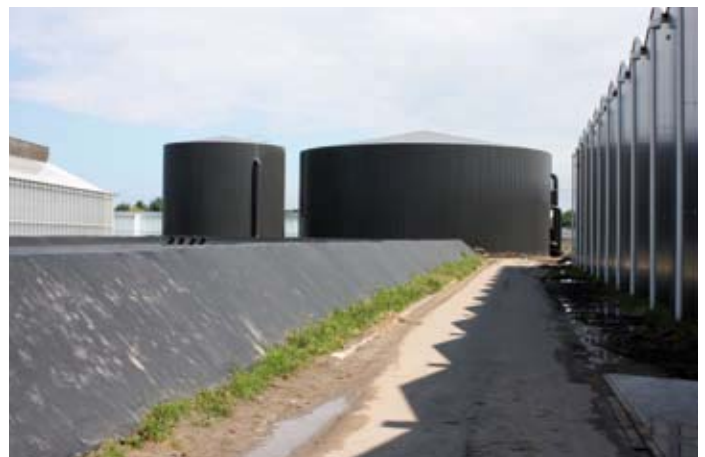
Immenser Technologieinput verwischt die Saisongrenzen: Links der Maschinenraum, wo im Winter die Wärme und im Sommer die Kälte fliesst. Rechts das Auffangbecken für Regenwasser und im Hintergrund die Zwischenspeicher für das gekühlte respektive warme Wasser aus dem Untergrund.
