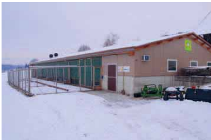
Biglers 2000er Biolegehennen-Stall ist in einer neuen 40-mal-12-Meter-Halle untergebracht.
