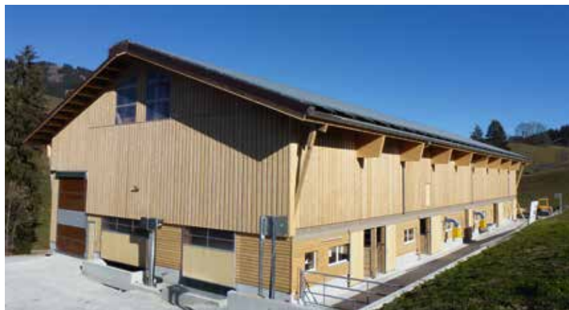
Die Abwärme von Photovoltaikanlagen kann für die Heubelüftung genutzt werden.
