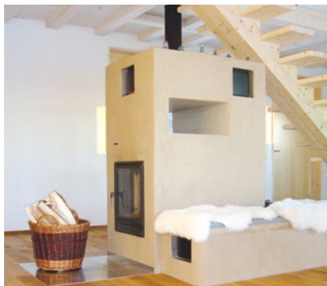
Reicht die Sonnenwärme von der grossen Fensterfront einmal nicht aus, heizt Agi Gehrig ihr Haus mit dem selbst gebauten Lehmofen. Bild: zVg
