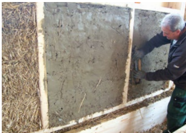
Die Dinkelstrohisolation wurde im Dönihus mit Lehm verputzt. Bild: zVg
