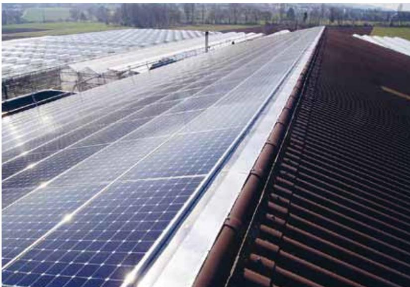
Diese Anlage auf dem Betrieb Bioland von Stephan Müller, Steinmaur ZH, erreicht eine Spitzenleistung von 174,72 kWp und umfasst eine Bezugsfläche von 893 m<sup>2</sup>.
