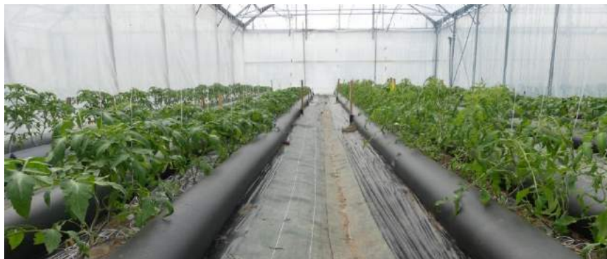
Das Thermitube-System in Tomaten Bild: Firma Thermitube
